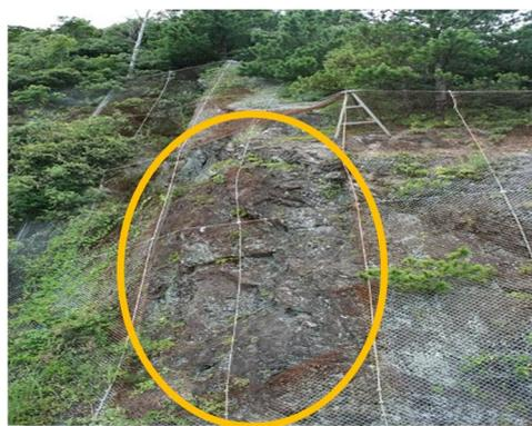
写真 落石防護網の著しい腐食による断面欠損の例
