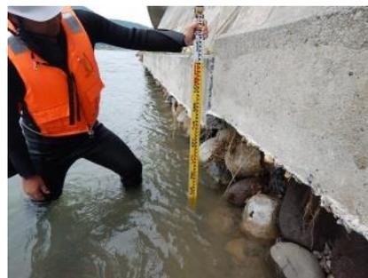
写真 擁壁基礎部・底盤部の洗掘の例
