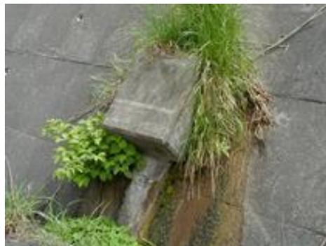
写真 アンカーの頭部からの湧水・雑草の繁茂の例
