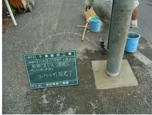
図－２．２．２ 水切りコンクリートの施工事例
