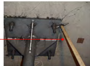
打音検査の例
