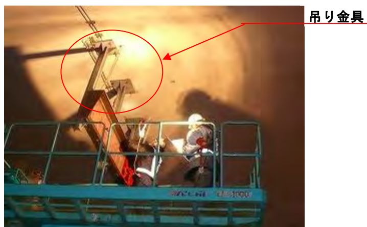
写真－解 3. 3 触診作業状況
