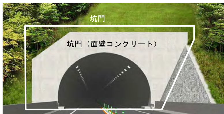
図一解 3. 3 標準的な点検対象箇所（トンネル坑口部）
