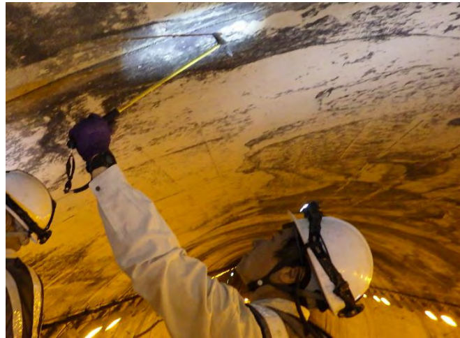
(a) トンネル本体工
