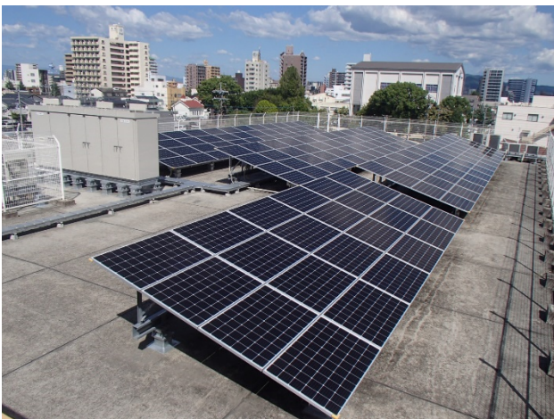
▲太陽光発電出力 52.1kW、蓄電池容量 89.2kWh の設置例
