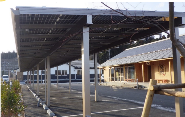
▲カーポートに設置した太陽光パネルやパワーコンディショナ等の設置例
