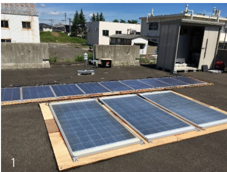
1/太陽光発電パネル(手前:車両用 3 枚、奥:歩行者用 10 枚)と蓄電池システム等を収めたユニットハウス
