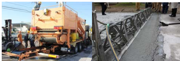
図-1 モービル車による練混ぜと表面仕上げ
