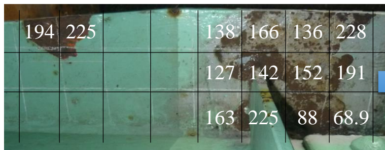
CS工法施工前の初期鍍厚
