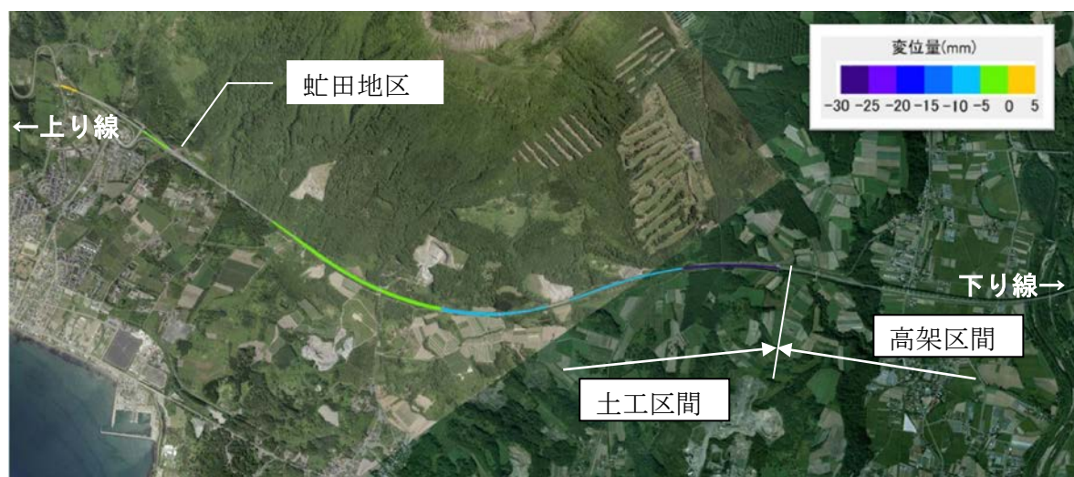
図 6.2.1-7 虻田地区周辺の路面の変状状況（「－」が沈下）
