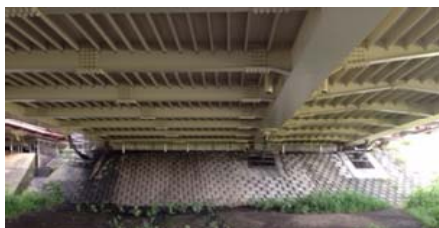
図 20 対象橋梁の桁下の外観
