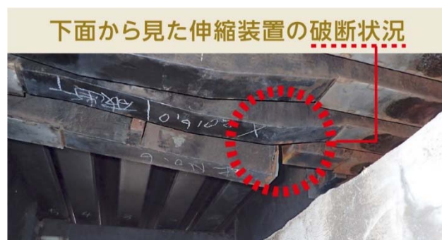
図4 中日本高速道路株式会社 HP 伊勢湾岸道 昼夜連続・車線規制
