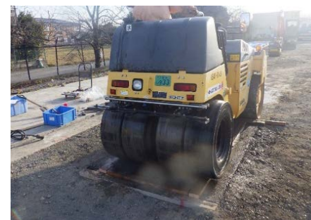
特殊アスファルト混合物転圧
