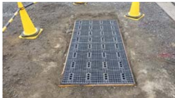
雨水浸透材設置
