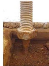
ボルト基部の腐食
