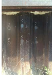
図1 用水路での鋼矢板損傷評価結果(ELECT とケレン後の超音波計測結果の比較)
