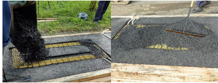
(a)アスファルト敷設 (b)アスファルト敷均し 図 30. アスファルト混合物への直接埋設状況 (型枠7)
