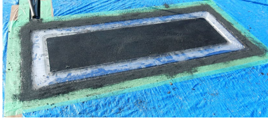
図 66. 円形走行路 表層コイル設置状況
