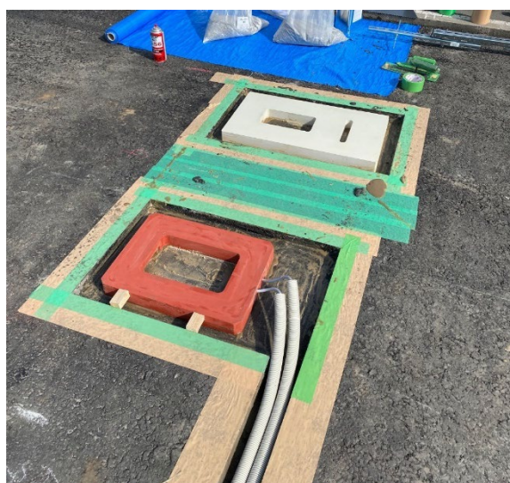
図 62. 超小型コイルの埋設の状況
