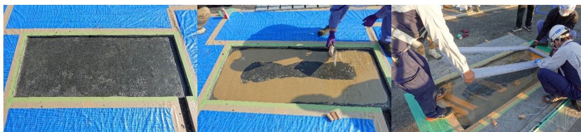
(a)コイル下面樹脂20mm舗設 (b)コイル下面接着剤2mm (c)ケースコイル設置
