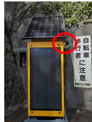
トンネル内自転車注意喚起システムの概観（赤丸：AIカメラ）
