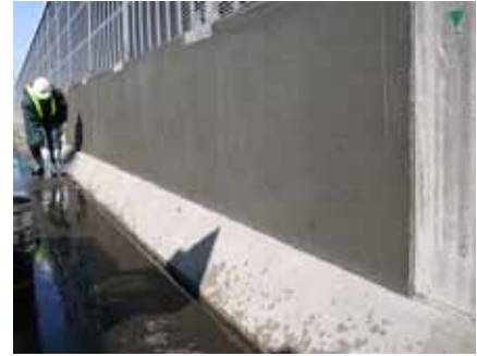
図-9 施工後の状況
