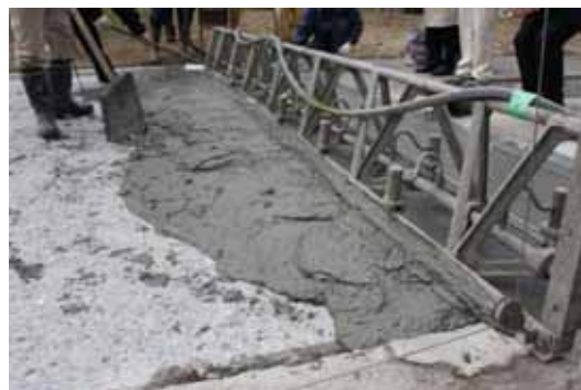
図-3 上面増厚の施工試験
