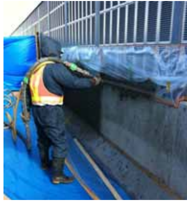
図-8 吹付けの様子
