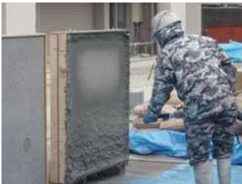
図-5 吹付けの様子
