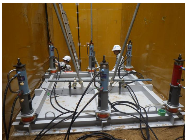
写真 3-12 複数の油圧ジャッキを用いたプレストレス載荷状況 (実物大実験時)
