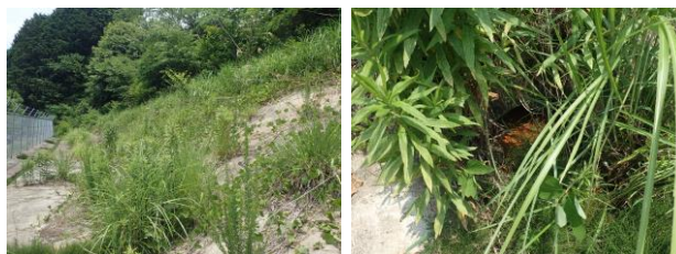
写真 2-2 対象盛土の下流部の状況
