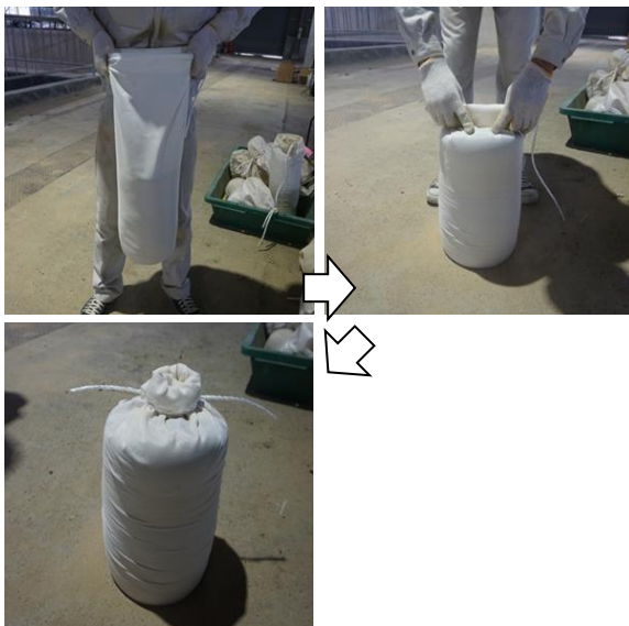
写真 3-10 土のう作成の手順
