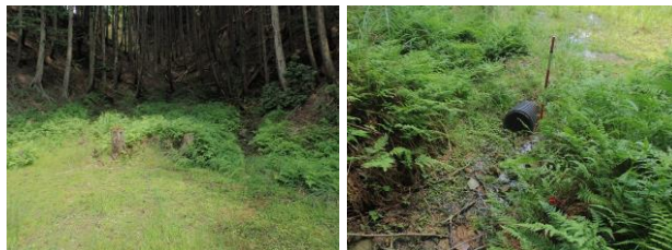
写真 2-1 対象盛土の上流部の状況
