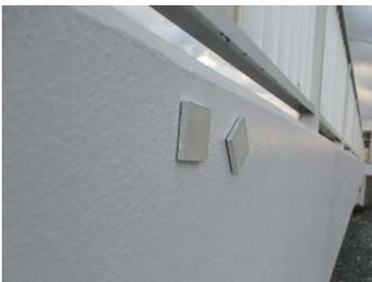
写真 2.2.1 供試体設置の様子（橋梁地覆側面）
