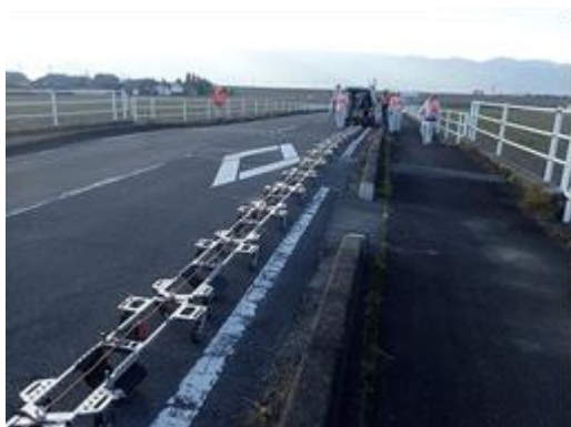
写真-1 2次元表面波探査測定状況
