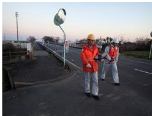
写真-2 牽引式電気探査測定状況
