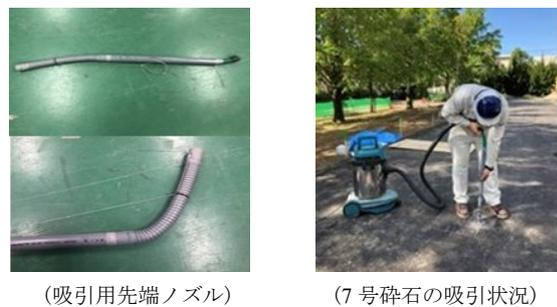
写真-3.1 空洞作製手順の主な状況
