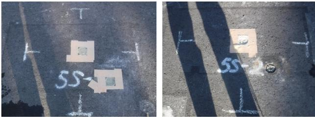
図-4.7 空洞補修用充填材 充填完了確認状況
