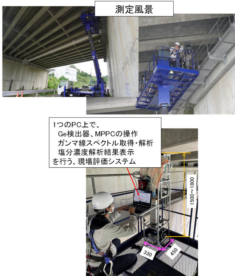
図 3 5 綱木跨道橋下の桁下フランジ下面の塩分計測試験
