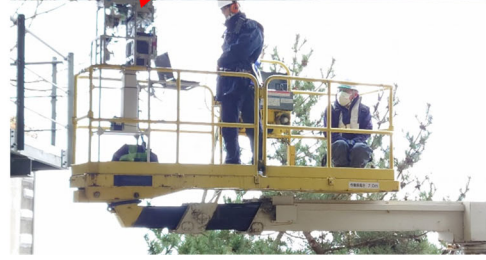
図 4 1 A2付近への移動と塩分計による計測の様子
