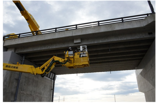
図 2 7 塩分計測試験を実施する耳桁フランジ付近までバケットを移動
