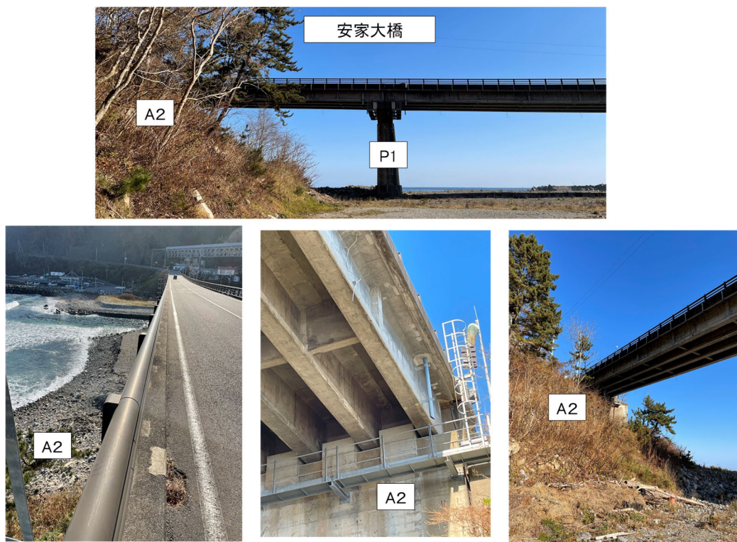
図3-7 安家大橋。計測箇所はA2付近の耳桁下面。撮影は計測試験の事前現場調査時。
