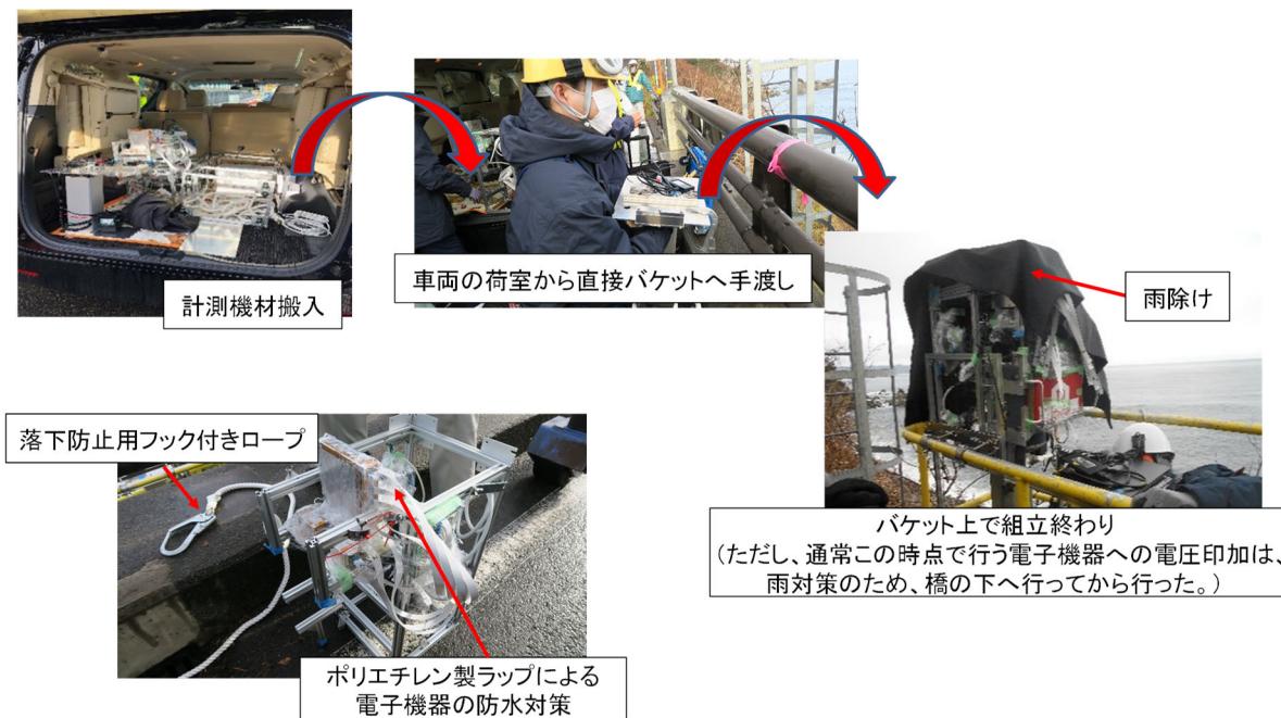
図40 車両の荷室からバケット上へ手渡しで組み立てた。電子機器にはラップで防水対策。パーツの落下防止にフック付きロープを使用した。
