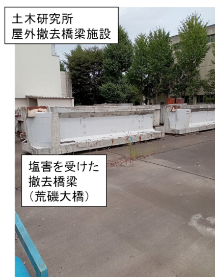
図 1 9 土木研究所屋外施設と撤去橋梁
