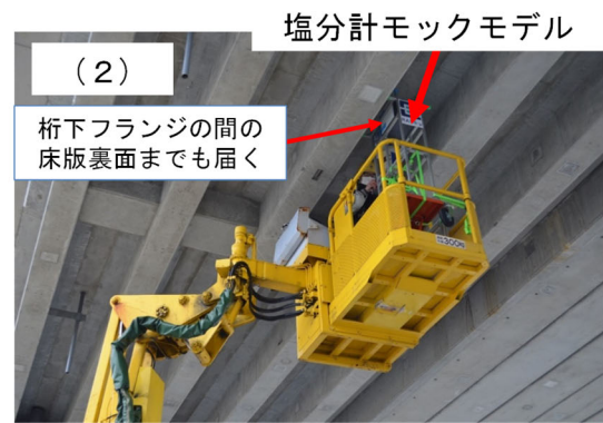
図16 (1) 橋梁下までバケットを移動。(2) 床版裏面近くまでバケットを移動。
