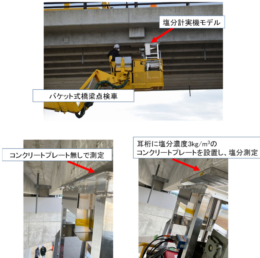
図 2 8 バケット上での塩分計測試験の様子。(中央上) 塩分計測試験を実施する耳桁フランジ。(左下) コンクリートプレートを設置しない場合の塩分計測。(右下) コンクリートプレートを設置した場合の塩分計測。
