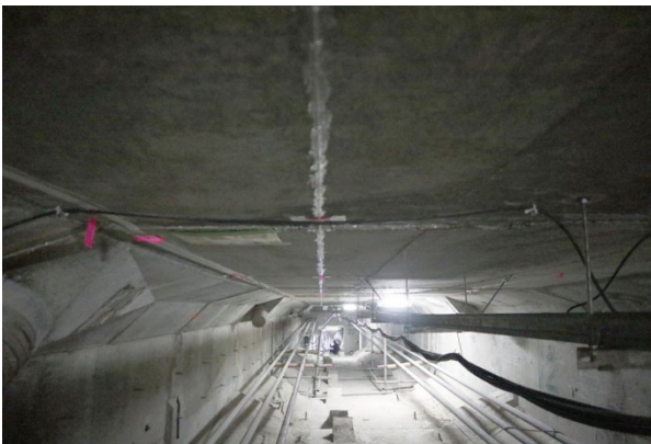
図-5.31 上床版に接着した光ファイバーケーブル
