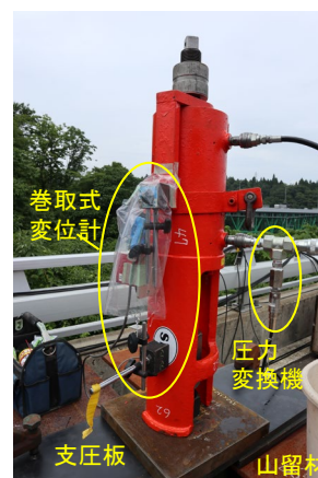
図-5.18 油圧ジャッキの状況
