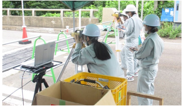
図-5.26 レベル計測の状況
