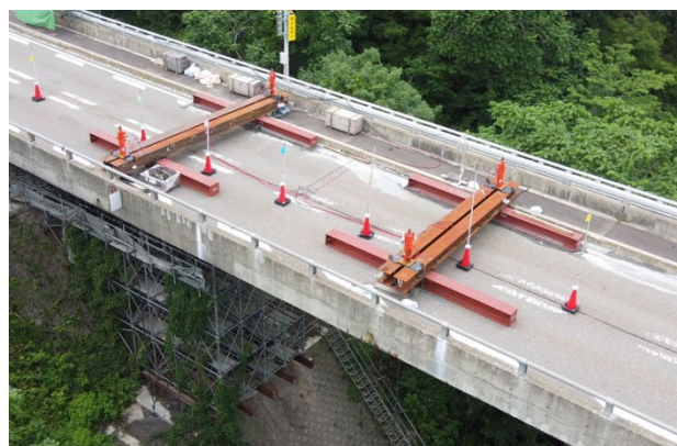
図-5.17 荷重装置の全景
