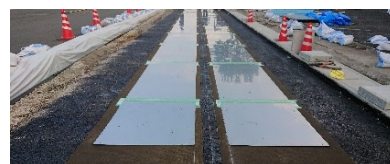
図-2 送電電極施工
