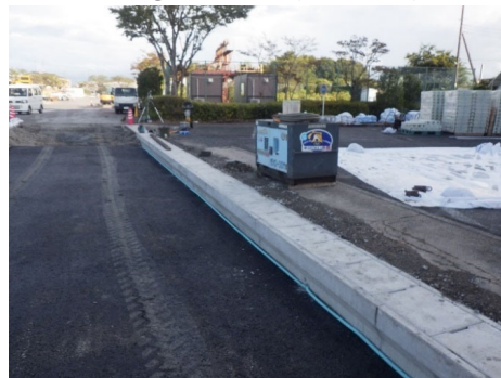
図-4. 28 ③施工基盤 (排水性) ドレーンパイプ設置
