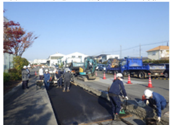
図-4.16 施工基盤（As 層）舗設状況
