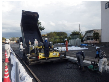
図-4. 29 ③施工基盤 (排水性 As) 舗設
