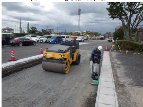
図-4. 26 ②施工基盤 (粒状路盤) 舗設
