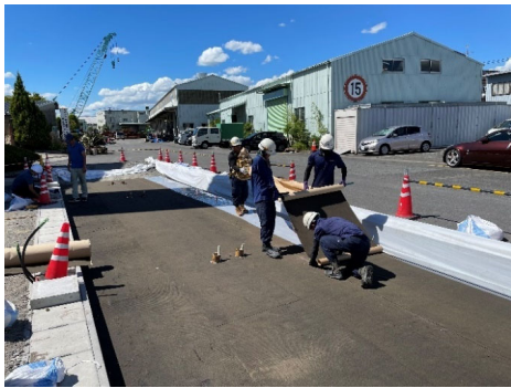
図-4.34 ⑦瀝青シート設置
