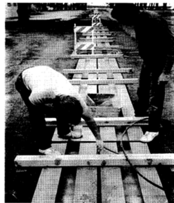
図-2.2 PATH プロジェクトでの送電コイル埋設施工の
