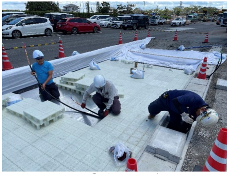
図-4.32 ⑥送電ケーブル設置
