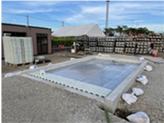
図-4.14 雨水浸透材（2段目）設置状況
