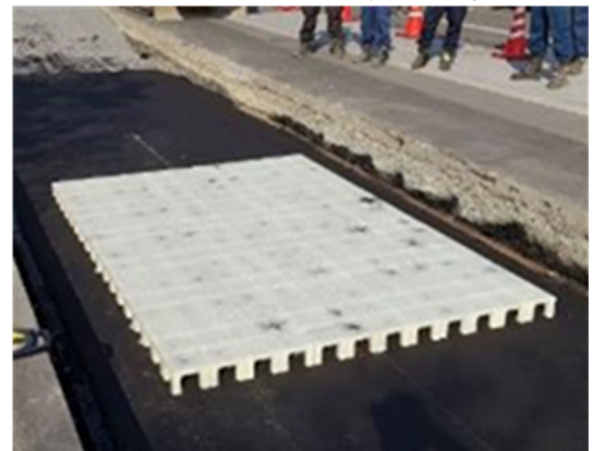
図-4.17 雨水浸透材（1段目）設置完了
