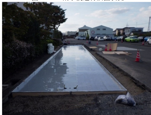
図-4.22 プラスチック平板設置状況
