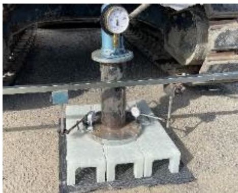
図-4.2 耐力確認試験状況
