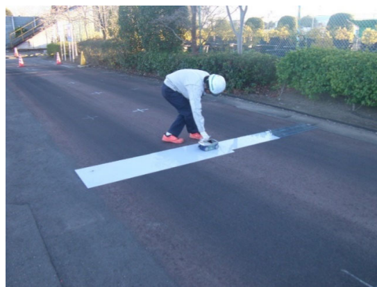
図-4.42 電磁波レーダ測定状況
