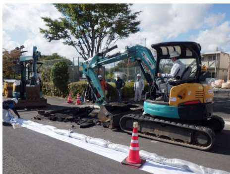
図-4. 25 ①既設舗装撤去
