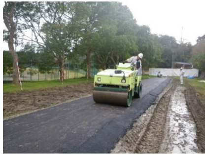
② 表層アスファルト施工
