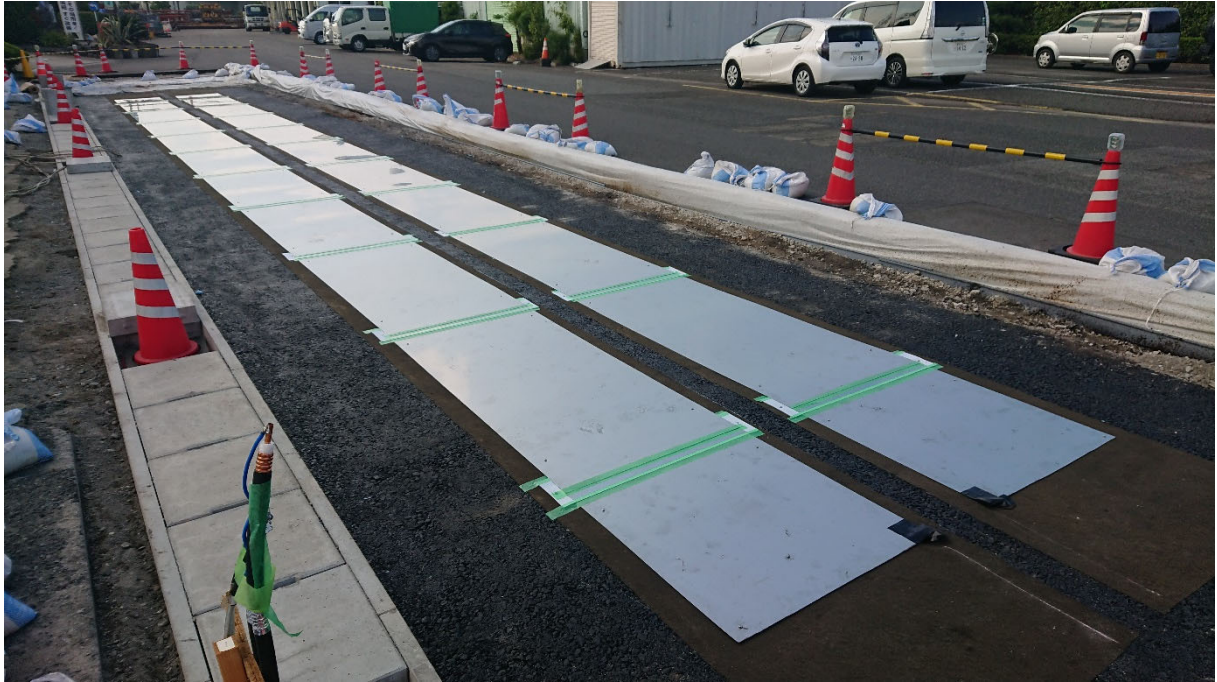
写真 5-8-2 絶縁シート施工例 2
