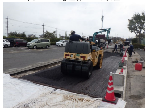
図-4.38 ⑩基層 舗設
