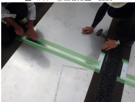
図-4.36 ⑨送電電極設置
