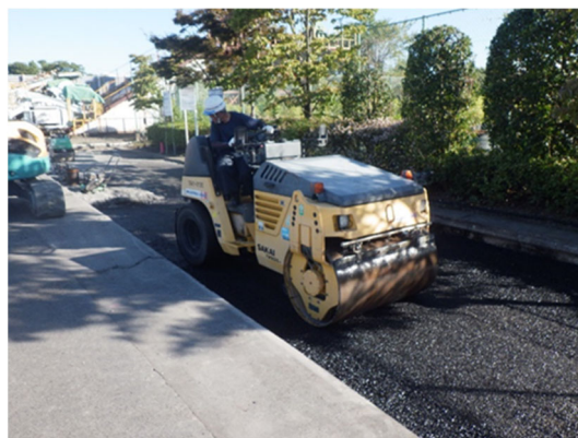
図-4.20 施工基盤 排水性 As 混合物施工状況
