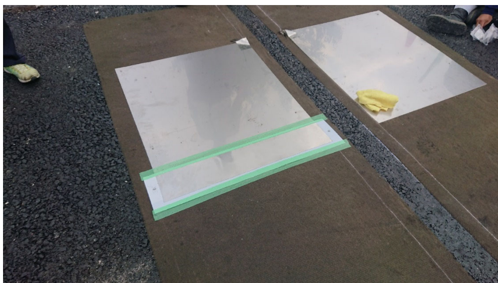
写真 5-8-1 絶縁シート施工例 1
