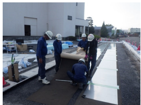
図-4.37 ⑨瀝青シート設置
