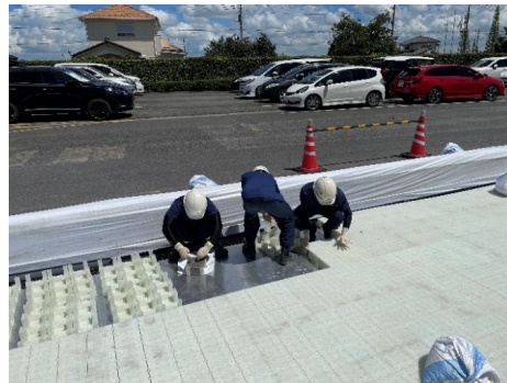
図-4. 31 ⑤雨水浸透材設置
