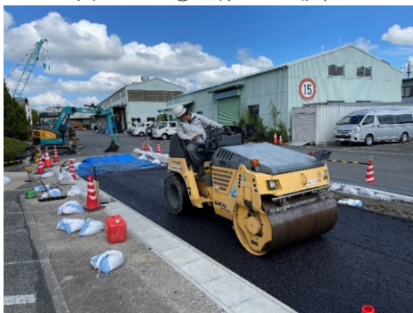
図-4.35 ⑧上層路盤 舗設
