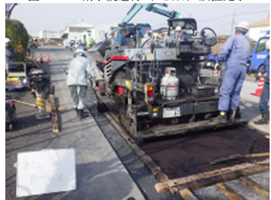
図-4.18 表層舗設状況
