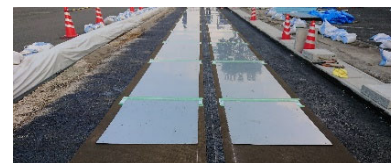
図-2 送電電極施工
