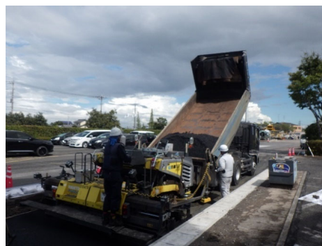
図-4. 27 ③施工基盤 (密粒度 As) 舗設
