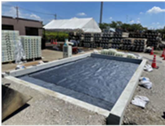
図-4.13 ジオテキシット設置
