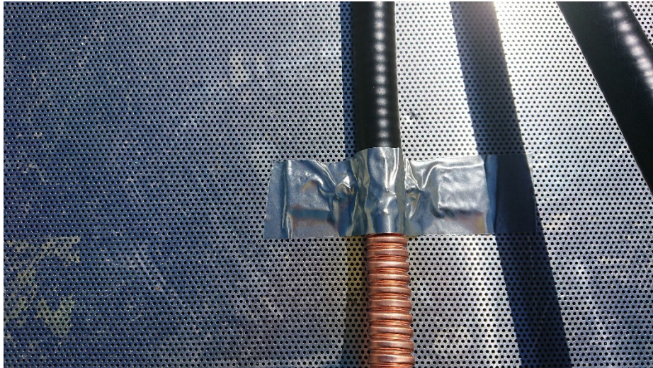
写真 5-7-2 接続部の保護（亜鉛テープ）
