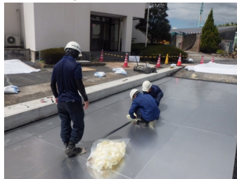
図-4. 30 ④グラント設置
