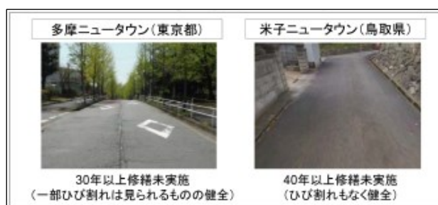
図2.7 長期間経過しても健全な生活道路の事例
