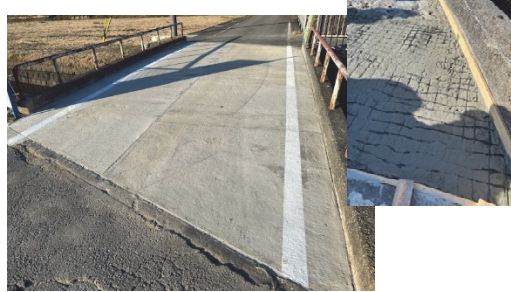
図-5 上面増厚補修後の橋梁
