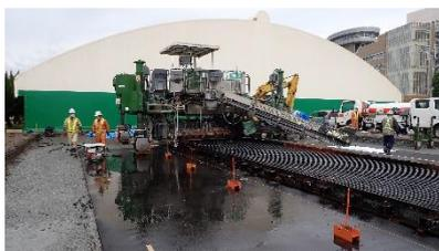
写真 2.1-2 スリップフォームペーバ施工状況
