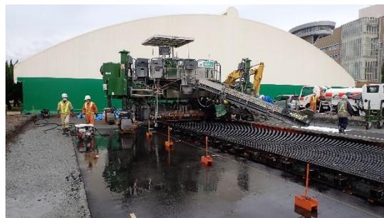
写真-2 スリップフォームペーパーによる施工状況
