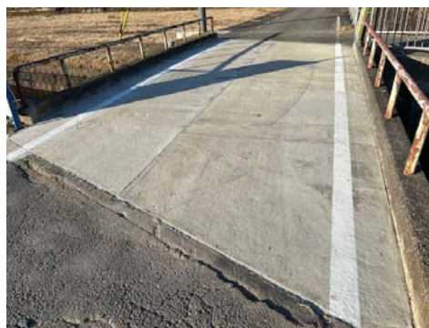
図－6.6 施工後の状況
