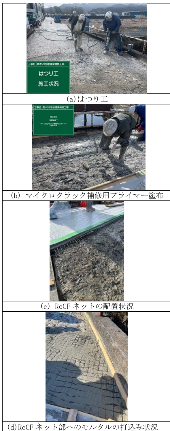
図－6.5 施工の各段階の状況
