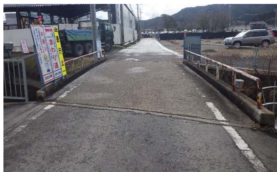
図-6.1 対象橋梁の全景
