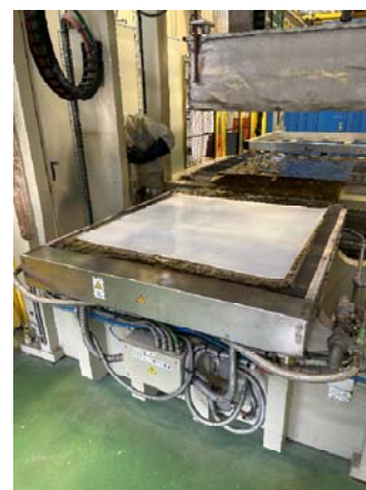
(b) 耐熱シートおよびシリコーンゴム設置状況
