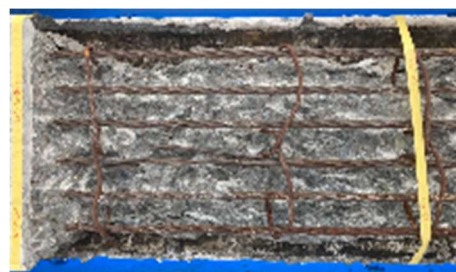
図4.20 PC実橋梁から切り出した桁部材
