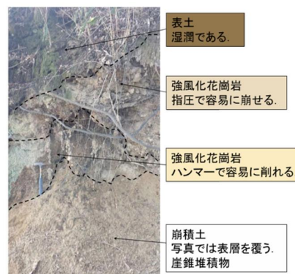
図 3-2 現場斜面の地質 3-2)
