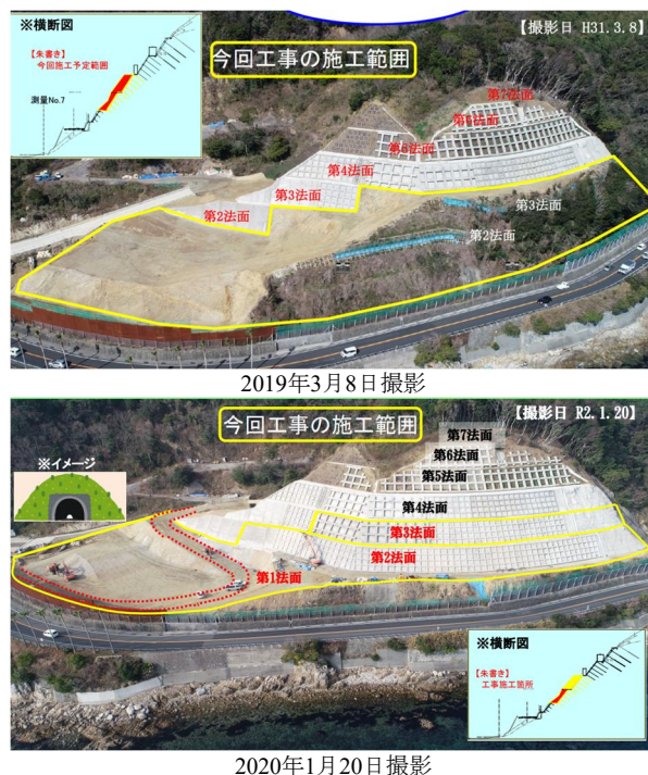
図6-11 バイパス建設箇所の施工状況
