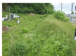
(a)土堤, 図 6.11 実際の土堤 12 (ソイルセメントで構築)
