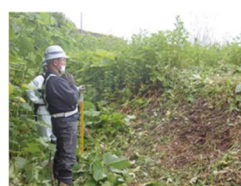
(a)土堤法面、
