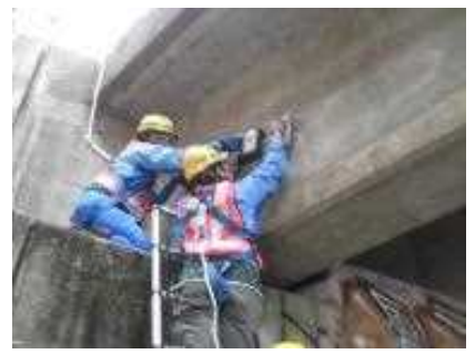
磁気の磁束密度を測定し内部の損傷を把握 <掲載技術名> 磁気による鋼材破断の非破壊検査法(SenrigaN) (検出項目:破断)
