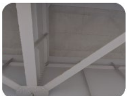
ひずみ補正・ひびわれ検出
