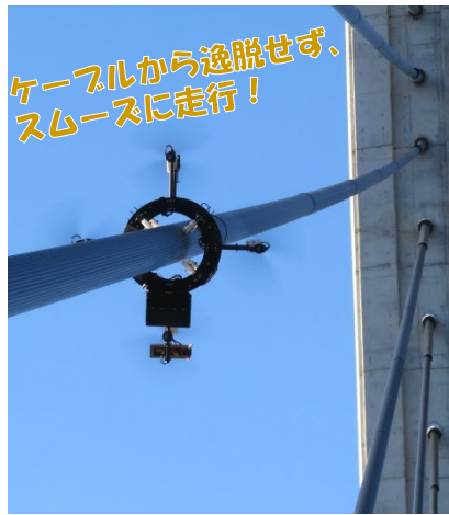
点検状況(1ケーブルあたり10分程度)
