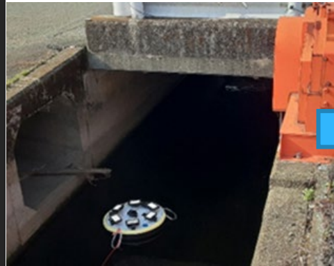
構造物の撮影 画像計測技術の活用
