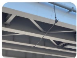
全方位カメラにて点検
