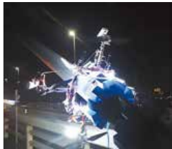
夜間点検状況
