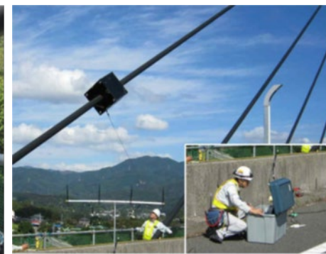
調査・点検実施
