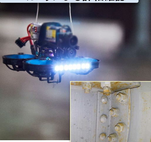
4Kカメラによる詳細確認
