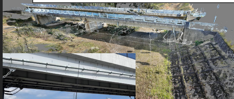
撮影データから作成した点群データ
