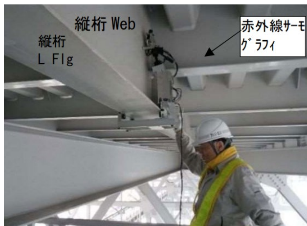
縦桁走行装置をつけたの Uリブ調査作業状況
