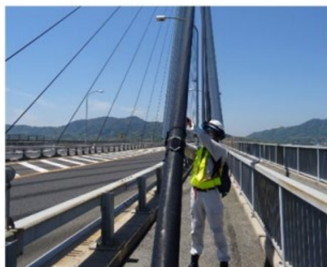
斜張橋ケーブル計測状況
