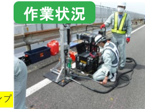
①削孔(標準径10.5mm)
