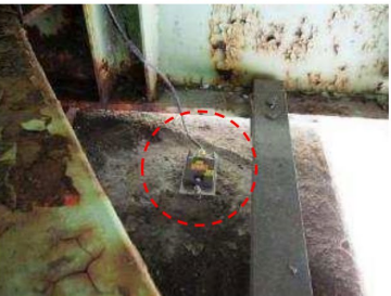
写真-1.3 傾斜計設置状況
