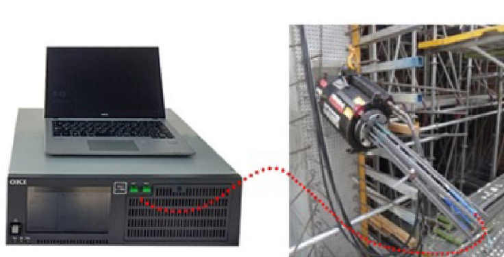
<施工時の計測状況>
