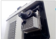
覆工の3次元形状計測
