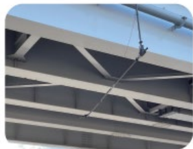
全方位カメラにて点検
