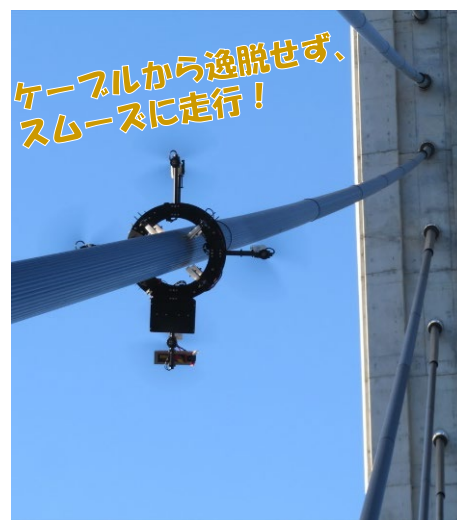
点検状況(1ケーブルあたり10分程度)
