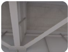
ひずみ補正・ひびわれ検出
