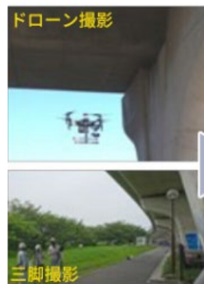
ひび割れ撮影
