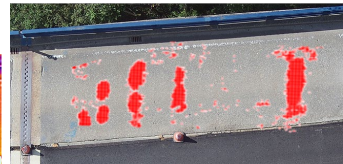
解析により床版劣化箇所を赤点で表示
