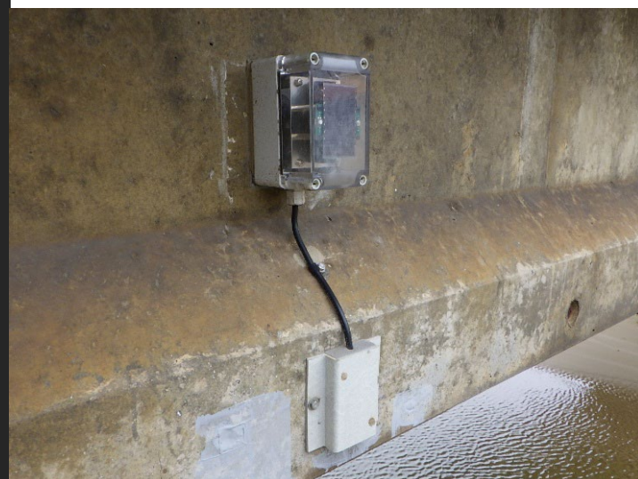
<橋梁下部への設置状況>
