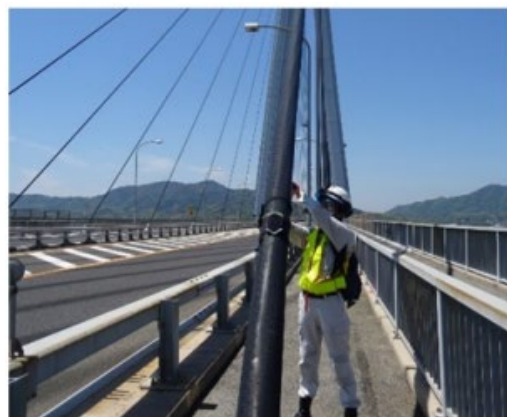
斜張橋ケーブル計測状況
