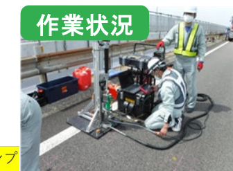
①削孔(標準径10.5mm)
