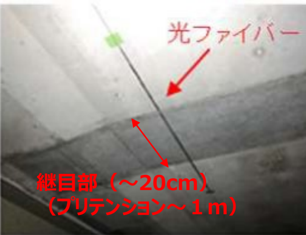
<光ファイバー設置状況>
