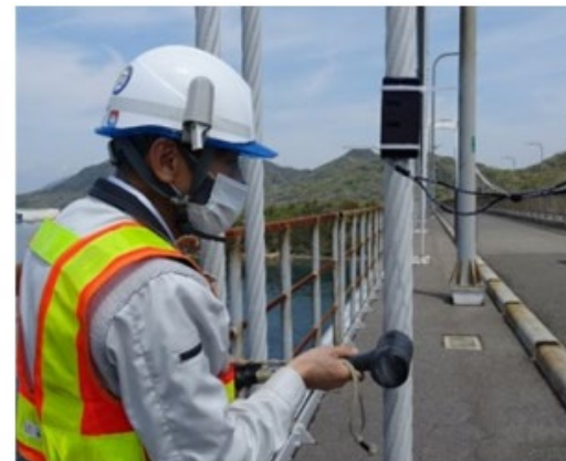
吊橋ハンガーロープ計測状況
