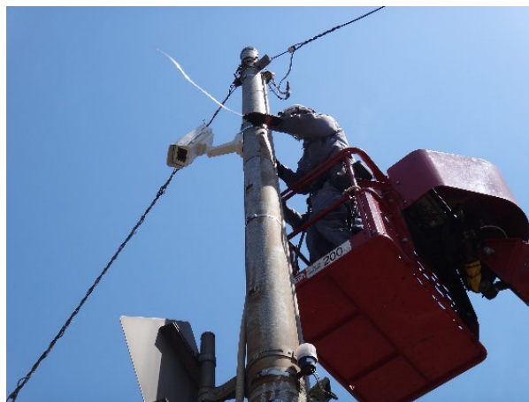
＜IPカメラの取付け状況＞
