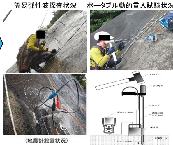
(地震計設置状況)
