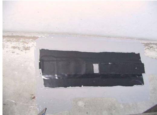
写真-4 疲労センサー貼付後状況(防水施工)
