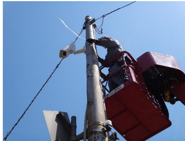
＜IPカメラの取付け状況＞
