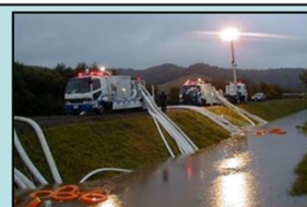
排水ポンプ車と照明車による排水作業
