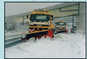
除雪トラックによる除雪作業
