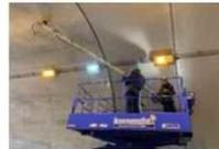
トンネル覆工の非破壊検査
