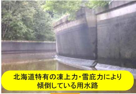
北海道特有の凍上力・雪底力により傾倒している用水路
