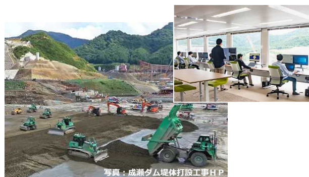
写真：成瀬ダム堤体打設工事HP
