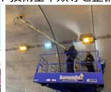
レーザーを利用した トンネル覆工の損傷把握
