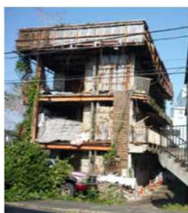
外壁が崩壊した事例
