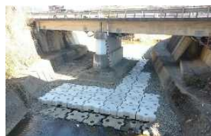
洗掘対策による流出防止
