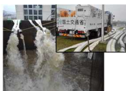
国土省の排水ポンプ車により雨水を配水
