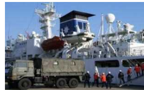
東日本大震災における耐震強化岸壁の活用
