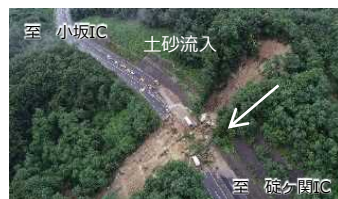
道路区域外からの土砂流入
