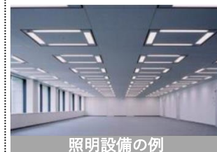
照明設備の例
