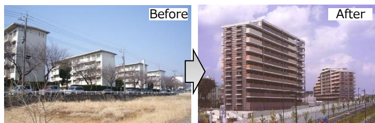
老朽化マンションの建替え事例(町田山崎地)
