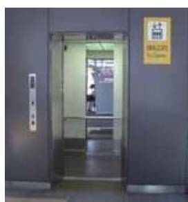
エレベーター
