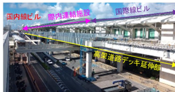
高架道路延伸整備中（R6年8月 現在）
