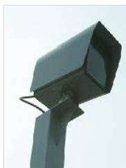
CCTVカメラ(全国約26,000台)
