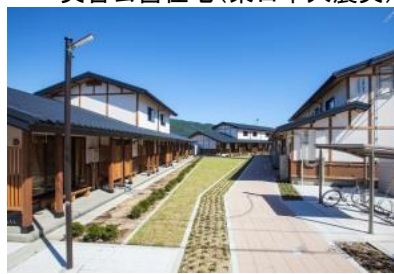
災害公営住宅(東日本大震災)
