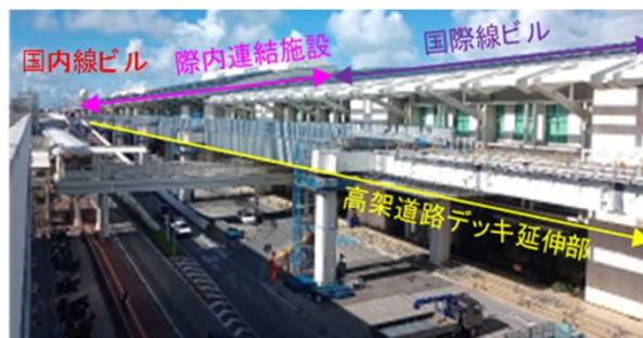
高架道路延伸整備中（R6年8月 現在）
