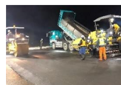
応急復旧状況
