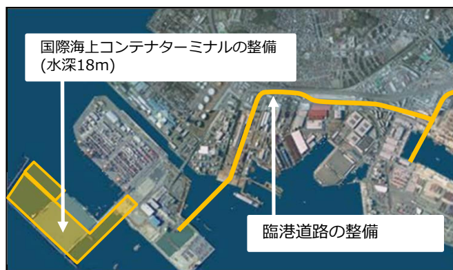
大水深コンテナターミナル・臨港道路の整備等により国際基幹航路を維持・拡大（横浜港）
