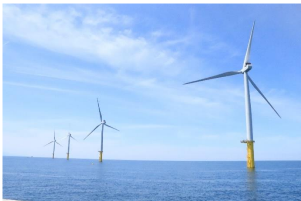
洋上風力発電設備の様子（秋田港）
