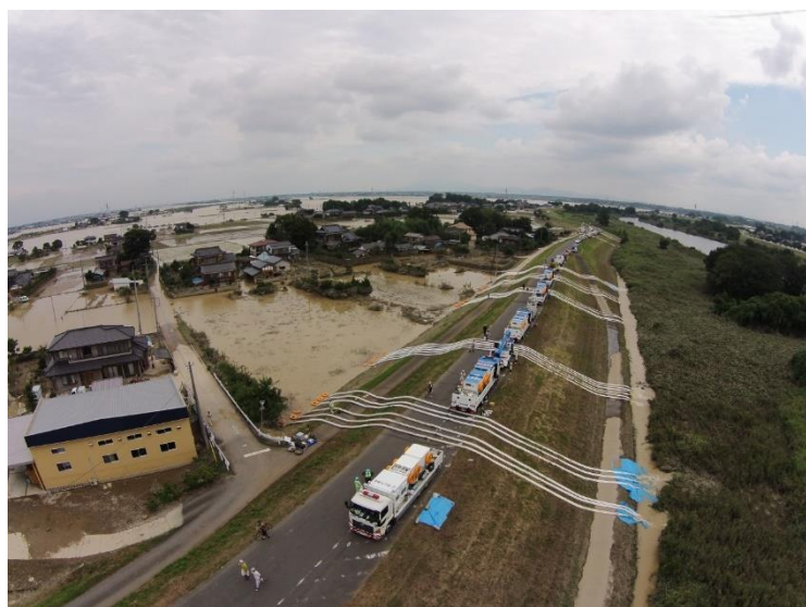
（上）遠隔操作による復旧作業（平成28年熊本地震） （左）平成27年9月関東・東北豪雨における排水作業
