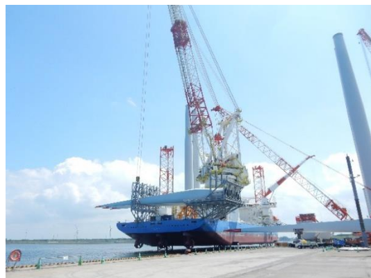
港湾での洋上風力発電設備の荷役作業の様子（石狩湾新港）
