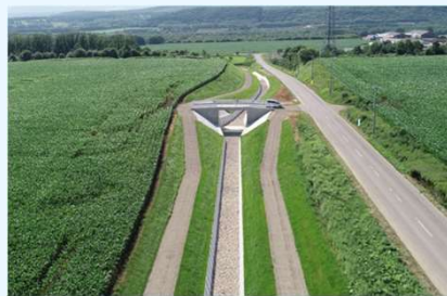
排水路の整備
