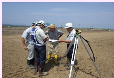
工事監督、施工管理
