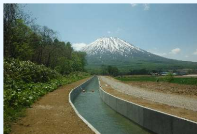
幹線用水路の整備
