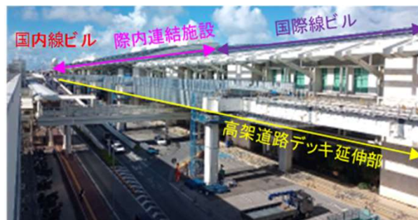
高架道路延伸整備中（R6年8月）
