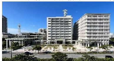
那覇第2地方合同庁舎(ビックコア地区)
