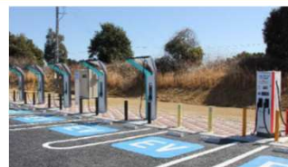
EV充電施設の設置
