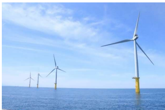
洋上風力発電設備の様子（秋田港）
