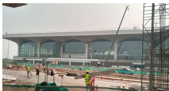
日本企業による海外の空港の建設状況 (バングラデシュ・ダッカ空港)
